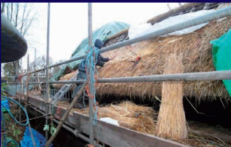
① ボランティアによる屋根の葺き替え風景
