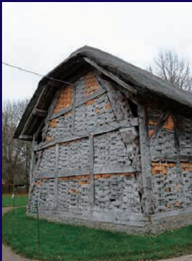
③ 新材（明るい部分）がはっきりとわかるような修理方法
