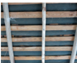
2 防水シートが貼られた屋根
