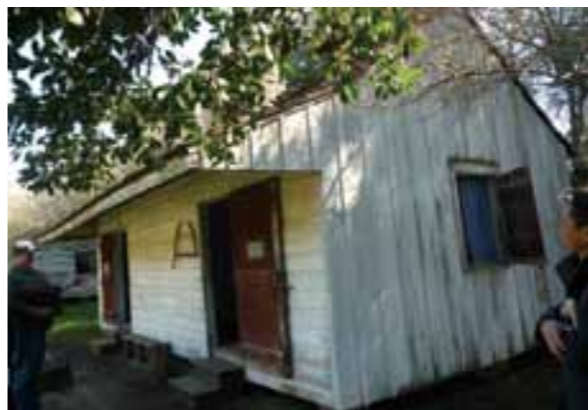
① 19世紀のプランテーションを再現した一画の奴隷小屋。この他、病棟、小学校、鍛冶屋、監督者の家、雑貨屋、厨房棟等が配置されている。
