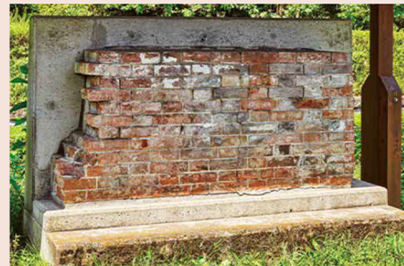
銀座煉瓦街の煉瓦壁
