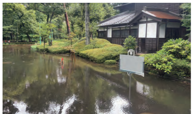
ゲリラ雷雨により池のように冠水した園内(高橋是清邸西側の通路)
