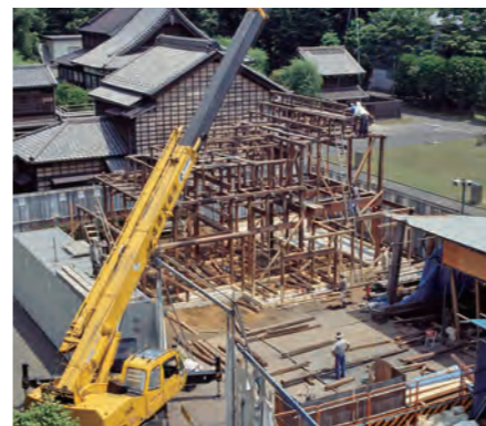
移築工事 1998年(平成10)
