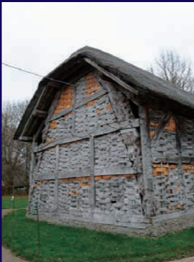
3 新材（明るい部分）がはつきりとわかるような修理方法
