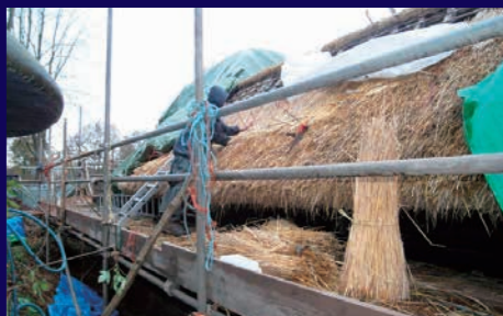
1 ボランティアによる屋根の葺き替え風景
