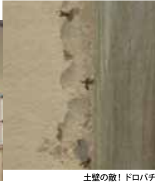
土壁の敵! ドロバチ
